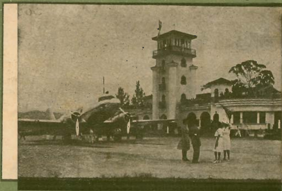
AEROPUERTO INTERNACIONAL "LA SABANA" — SAN JOSE - COSTA RICA
