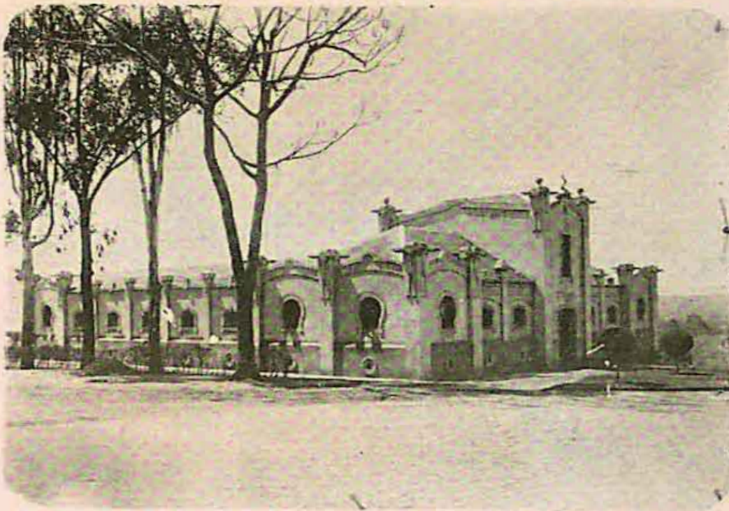
Curiosísimo edificio donde están instalados los establos con sus ventanas en forma de herradura.
