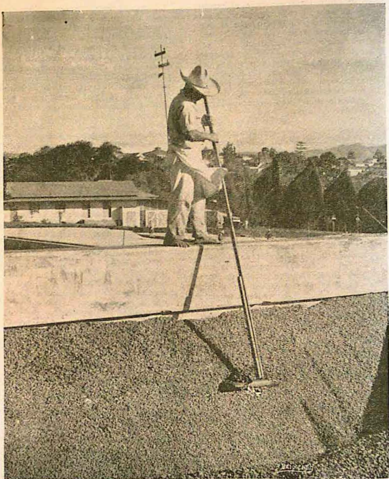
El café sale de las atargeas de concreto para los patios de deshidratación (Fotografía enviada al Concurso Fotográfico del I. D. C.)
