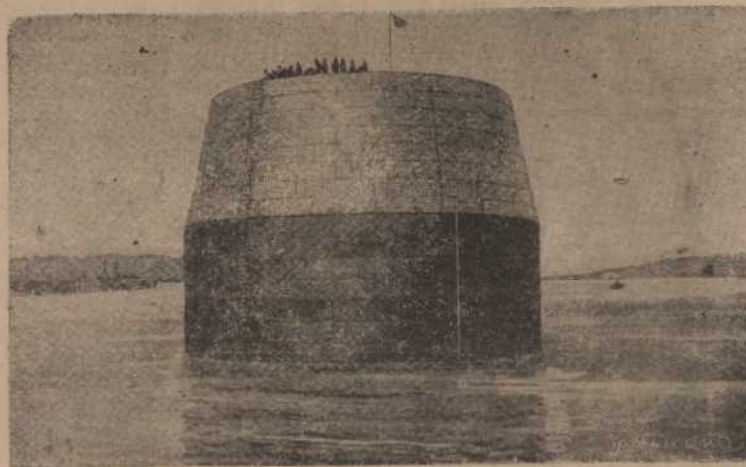
Cajón flotante a manera de cámara hueca, dentro del cual han de trabajar los obreros destinados a echar los cementos de un puente. Cuando este cajón llega al fondo del agua puede trabajarse en él seguramente.
