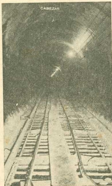
VISTA DE UNA SECCIÓN DEL TÚNEL CON EL ARCO DE CONCRETO TERMINADO
